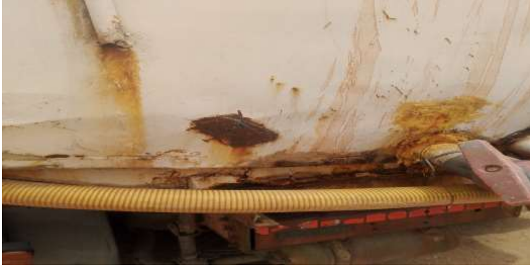
صورة توضح تآكل خزان نقل المياه الجوفية
