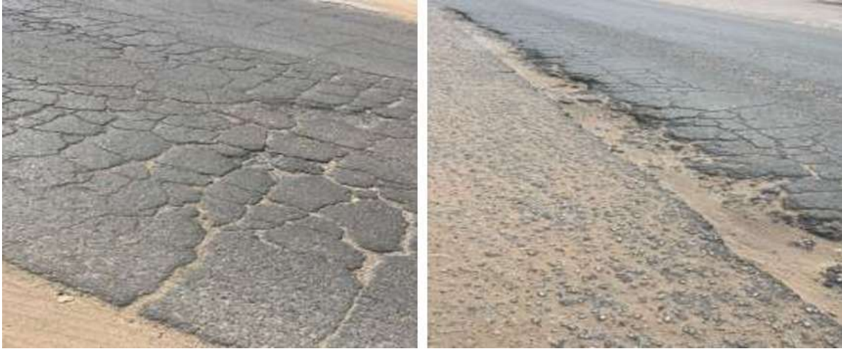
شكل رقم (4): ضعف الأكتاف وانقلاع حواف الرصف.
