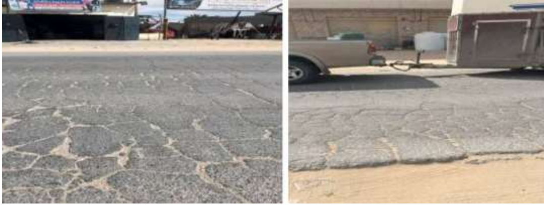
شكل رقم (1): انتشار التشققات التماسية وتفكك الحواف.
