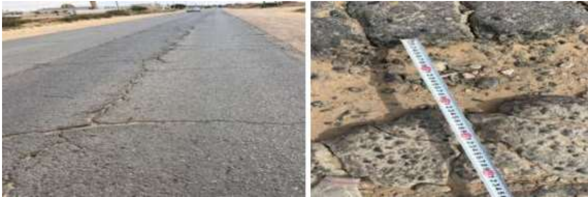
شكل رقم (2): انتشار التشققات الطولية والحفر.
