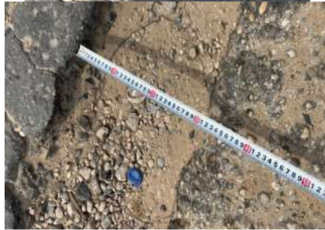
شكل رقم (3): توضيح تآكل السطح وقياس كتل التشققات.
